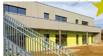
Die neue Kita Abenteuerland wurde in wenigen Monaten gebaut.
